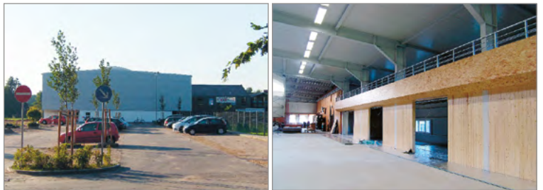
Neue Turn- und Sporthalle von Lübeck 1876 und Halleninneres mit Blick auf die Zuschauertribüne (noch im Bauzustand)
