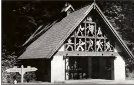
Das ehemalige Straßenbahn-Wartehäuschen mit den Holzschnitzfiguren, Originalzustand um 1940
