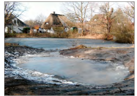
Abb. oben: Bei höheren Wasserständen kann der Teich in die neu angelegte Ausuferungsfläche (im Vordergrund) überlaufen.
