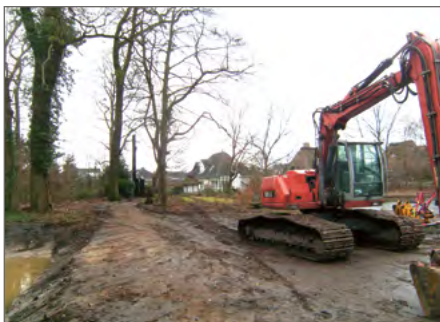
2018: Der neue Weg zum Ehrenmal wird angelegt
