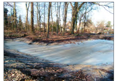
Abb. unten: Blick auf die neue Geländemulde südlich des Teiches. Diese steht durch einen Graben mit der Ausuferungsfläche in Verbindung.
